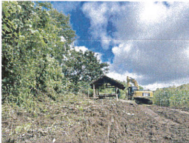
โครงการปรับปรุง/ซ่อมแซมถนน บ้านดอนแก้ว หมู่ที่ 2
