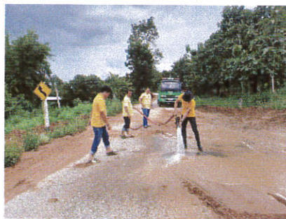
ทำความสะอาดถนน ระหว่างบ้านดอนเงิน -บ้านแม่ทวย
